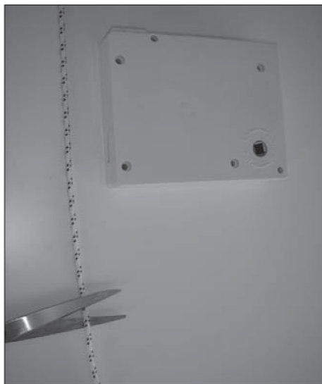
Knip het koord \pm 25 cm voorbij het koordwindwerk af.
